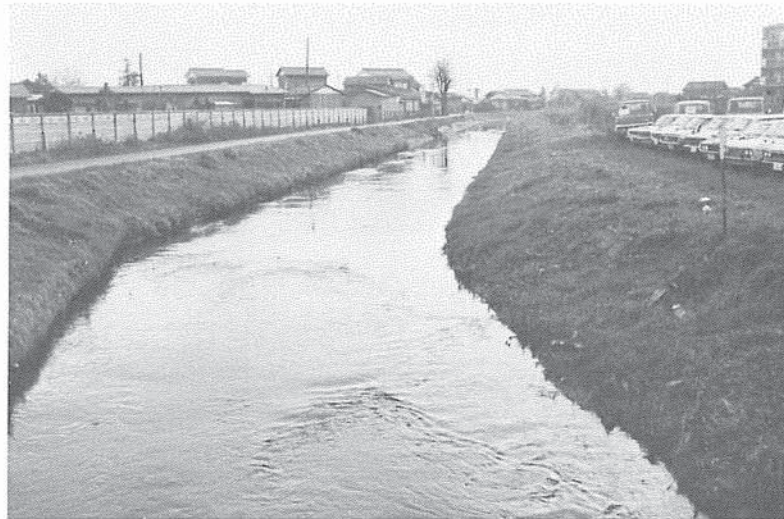
写真(12) 埼玉県熊谷市平戸
